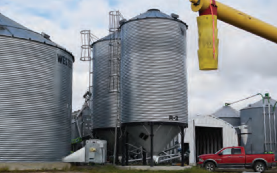
Une partie des installations de Services Agritem : l'entreprise se spécialise dans la fourniture d'intrants et le commerce du grain.
